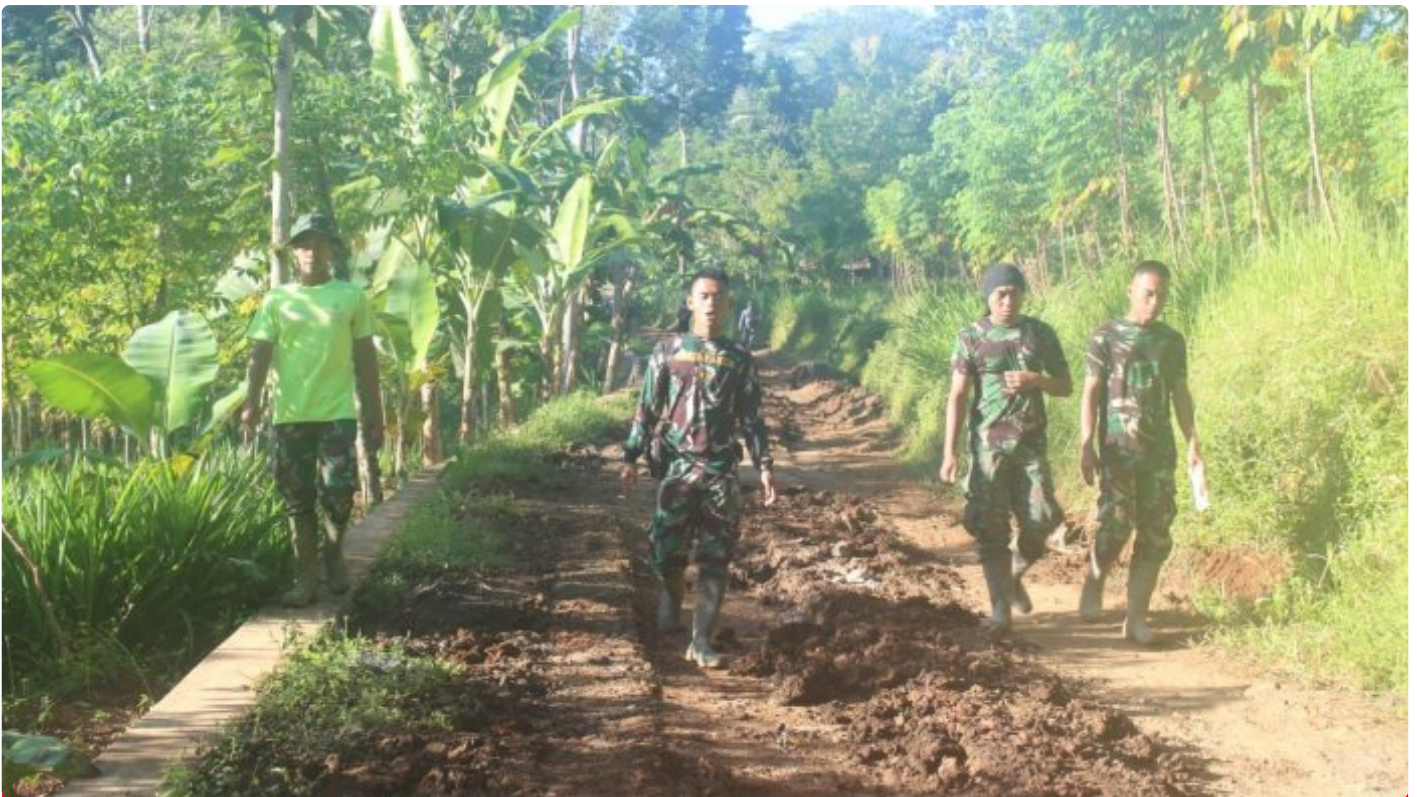
Anggota satgas TMMMD ke-116 Nampak bergegas menuju sasaran pengerjaan fisik
